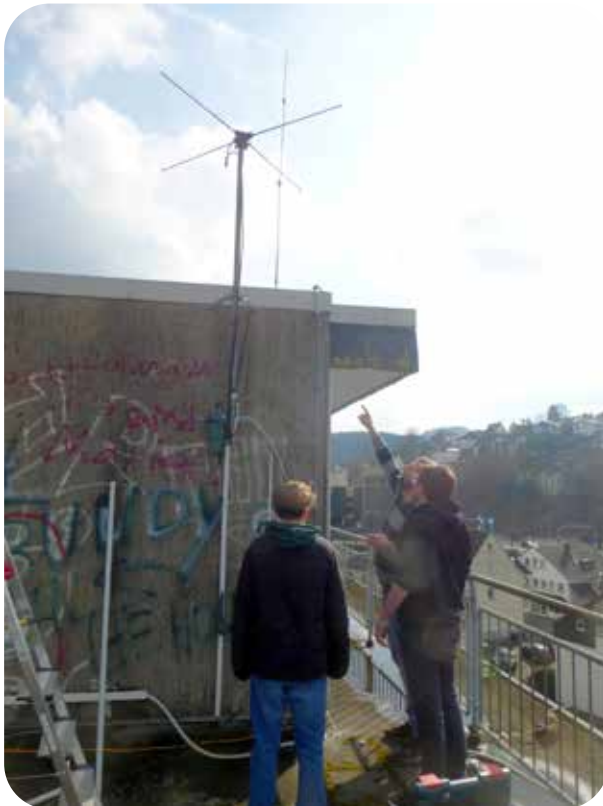
Lagebesprechung an der Antenne auf dem Dach des Rathauses
