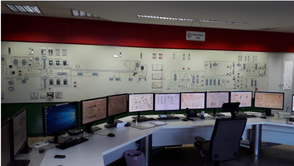
Abbildung 1: Leitwarte des Bitburger Kesselhauses
